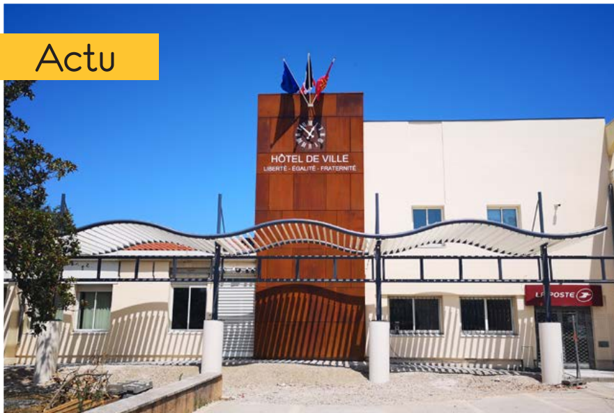
La rénovation de la façade de l'Hôtel de Ville prend forme !
